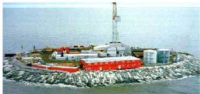
Отсыпаемый остров с укрепленными откосами
