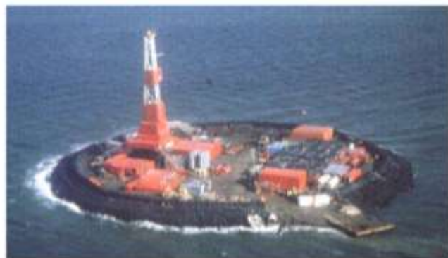
Намывные острова с укрепленными откосами
